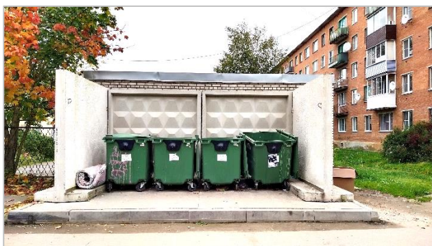
Рисунок 1.27 – Контейнерная площадка в г. Сланцы, ул. Ленина, в районе д. 19
