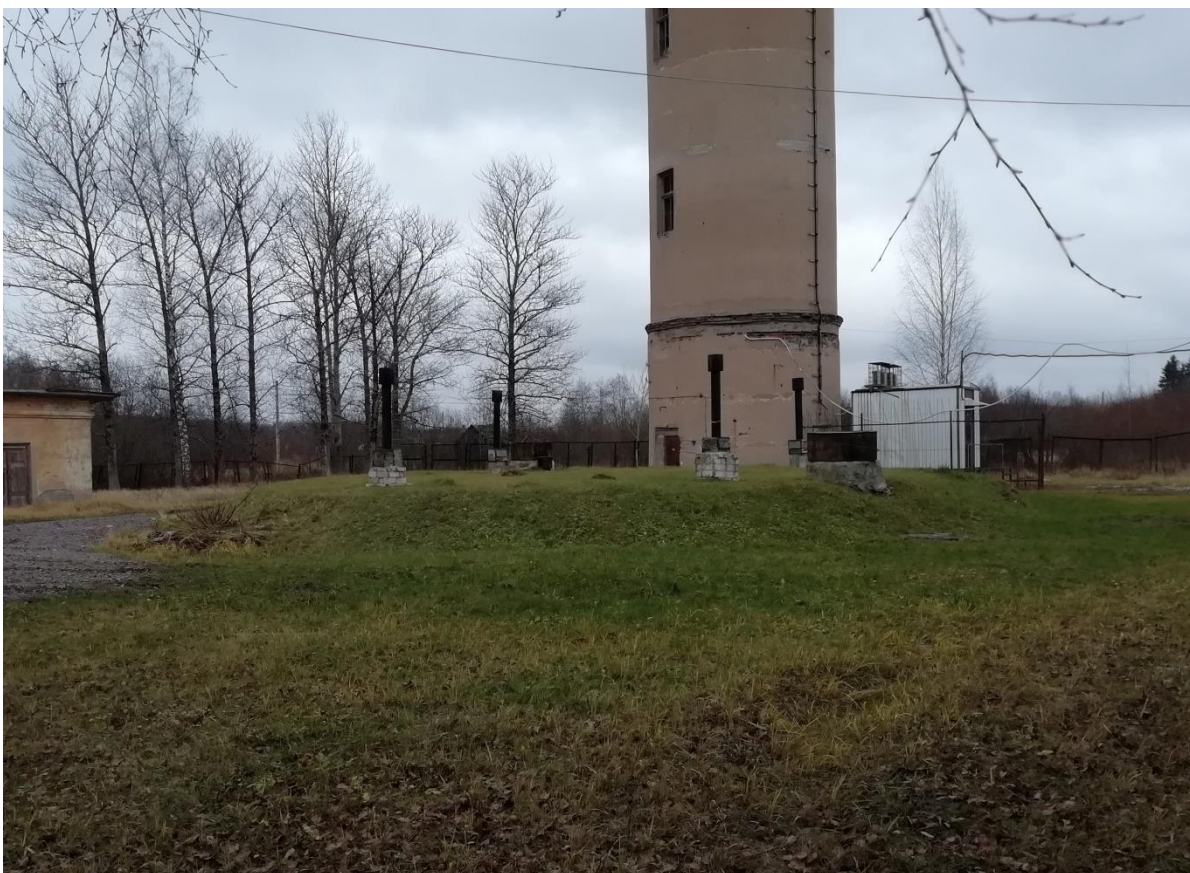
Рисунок 33. Внешний вид РЧВ-2 на площадке ВНС №2.
