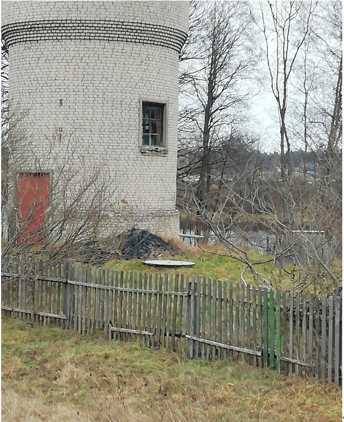
Рисунок 14. Водозаборные сооружения ОАО «РЖД».
