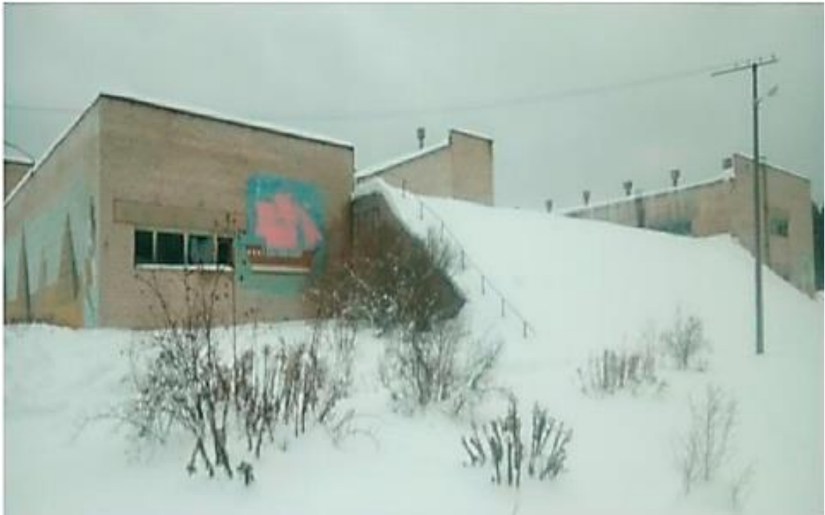
Рисунок 20. Водоочистные сооружения на р. Плюсса. Здание блока основных сооружений.
