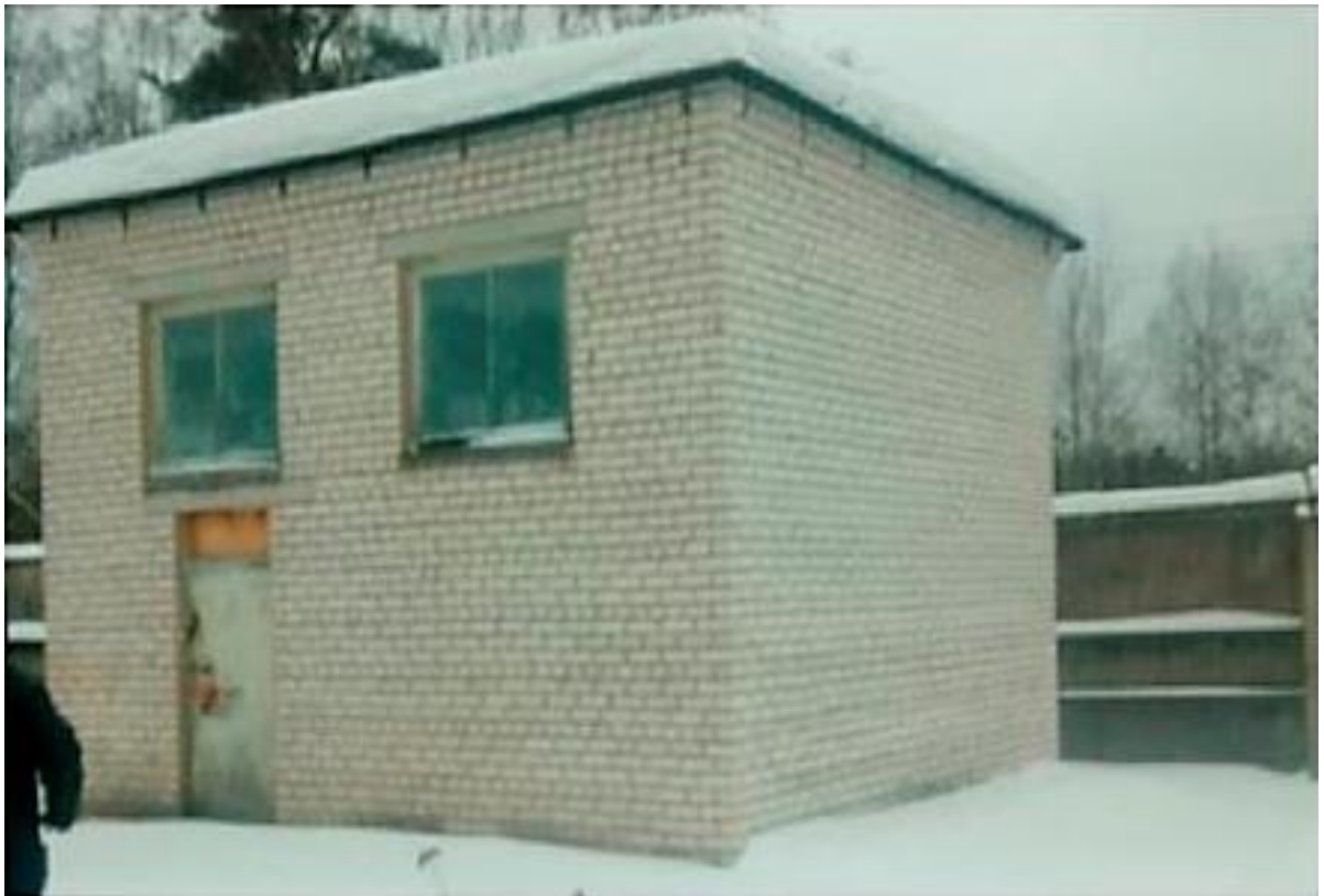
Рисунок 8. Водозаборные сооружения на р. Плюсса. Здание берегового колодца.
