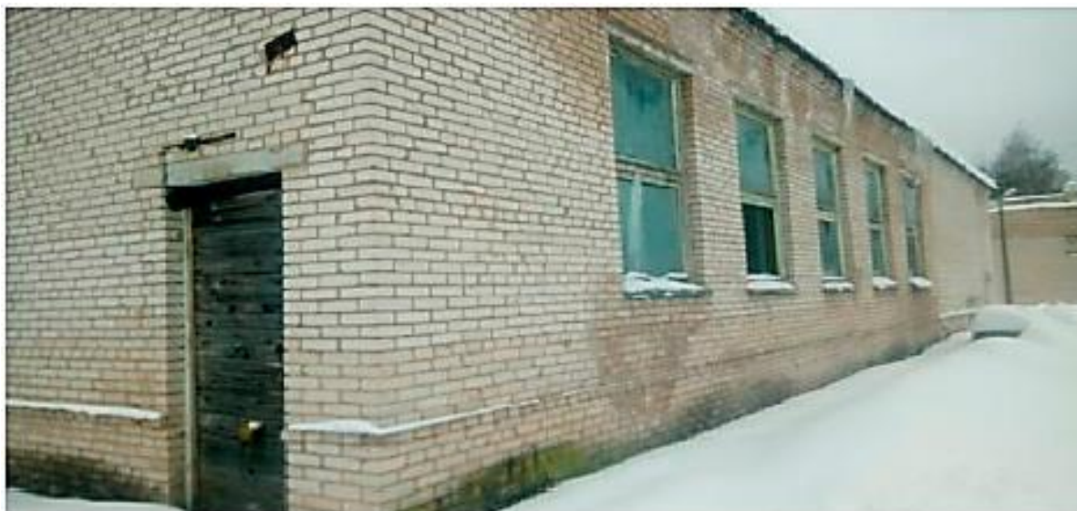
Рисунок 12. Водозаборные сооружения на р. Плюсса. Здание насосной станции I-го подъема.
