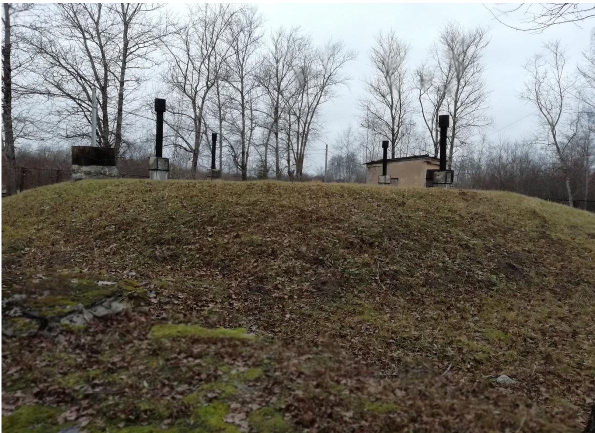
Рисунок 32. Внешний вид РЧВ-1 на площадке ВНС №2.
