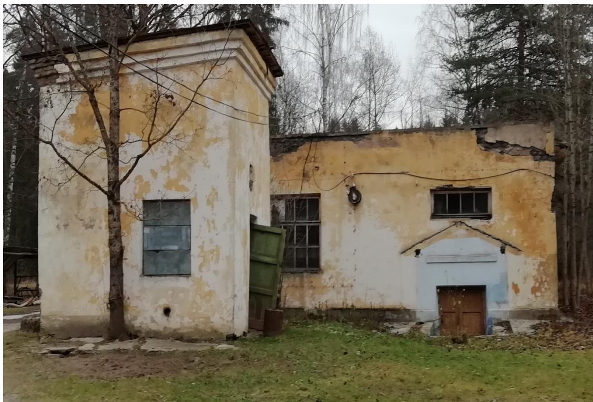
Рисунок 35. Внешний вид здания насосной станции III-го подъема ВНС №1.
