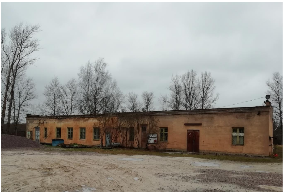
Рисунок 37. Внешний вид здания насосной станции III-го подъема ВНС №2.
