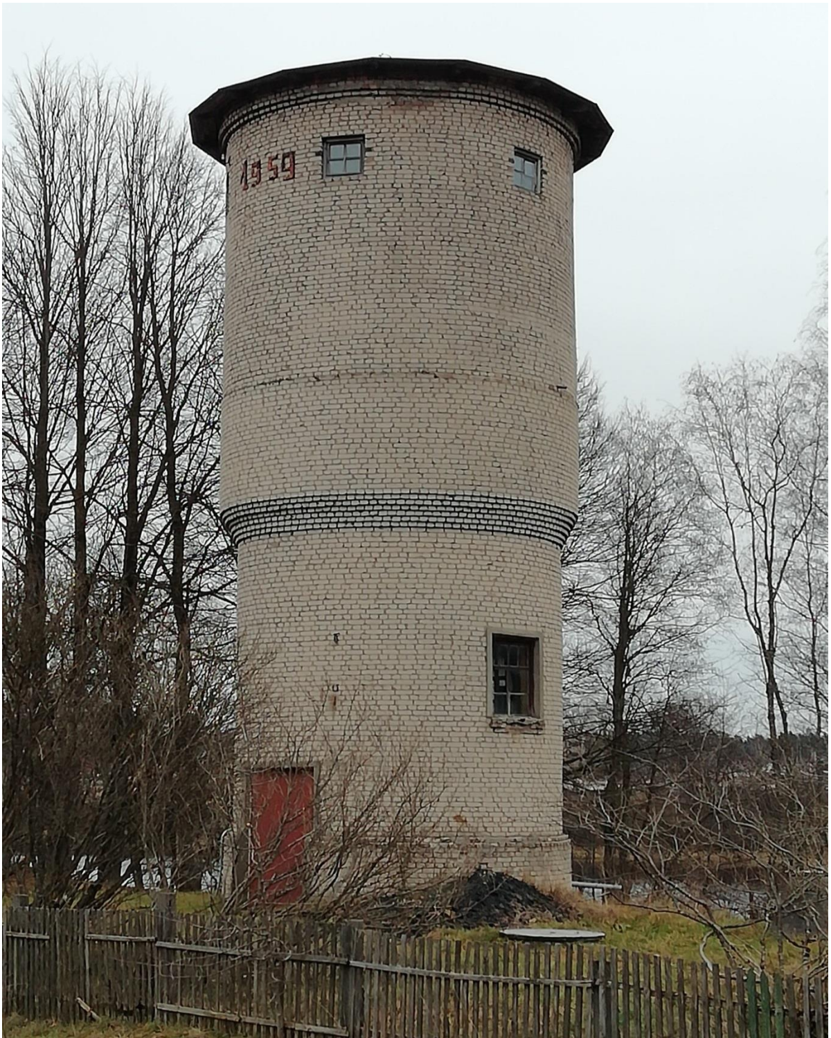
Рисунок 34. Внешний вид водонапорной башни ОАО «РЖД».
