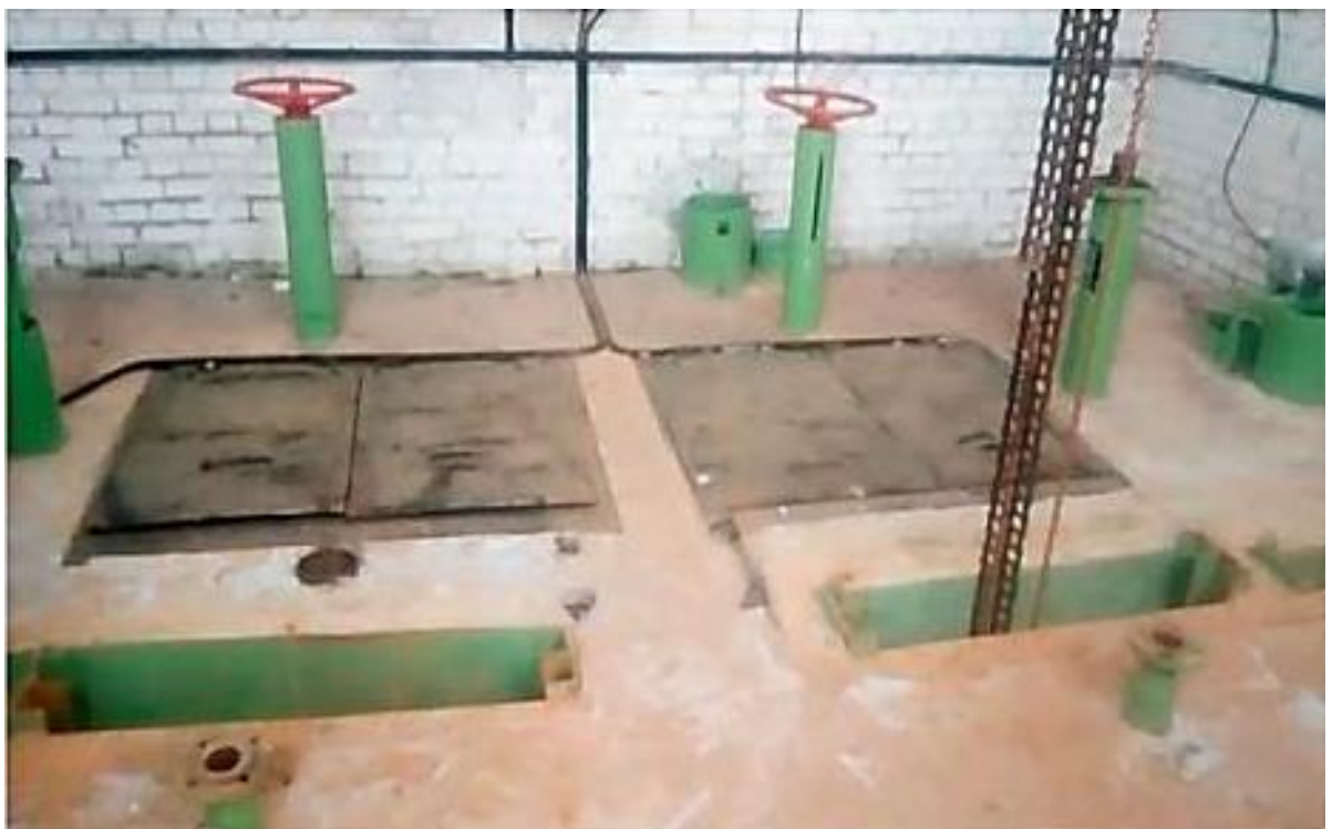
Рисунок 9. Водозаборные сооружения на р. Плюсса. Внутреннее помещение берегового колодца.
