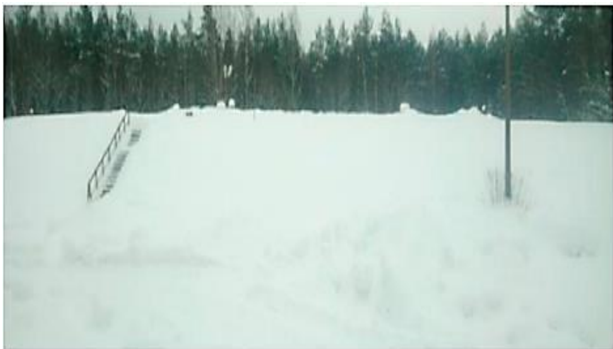
Рисунок 27. Водоочистные сооружения на р. Плюсса. Резервуар чистой воды.
