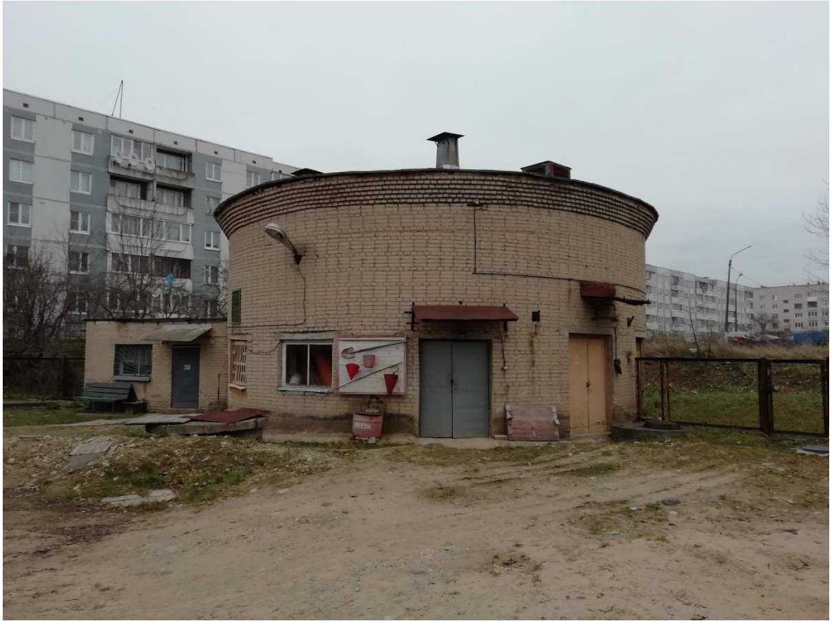
Рисунок 22. Внешний вид здания КНС №3.
