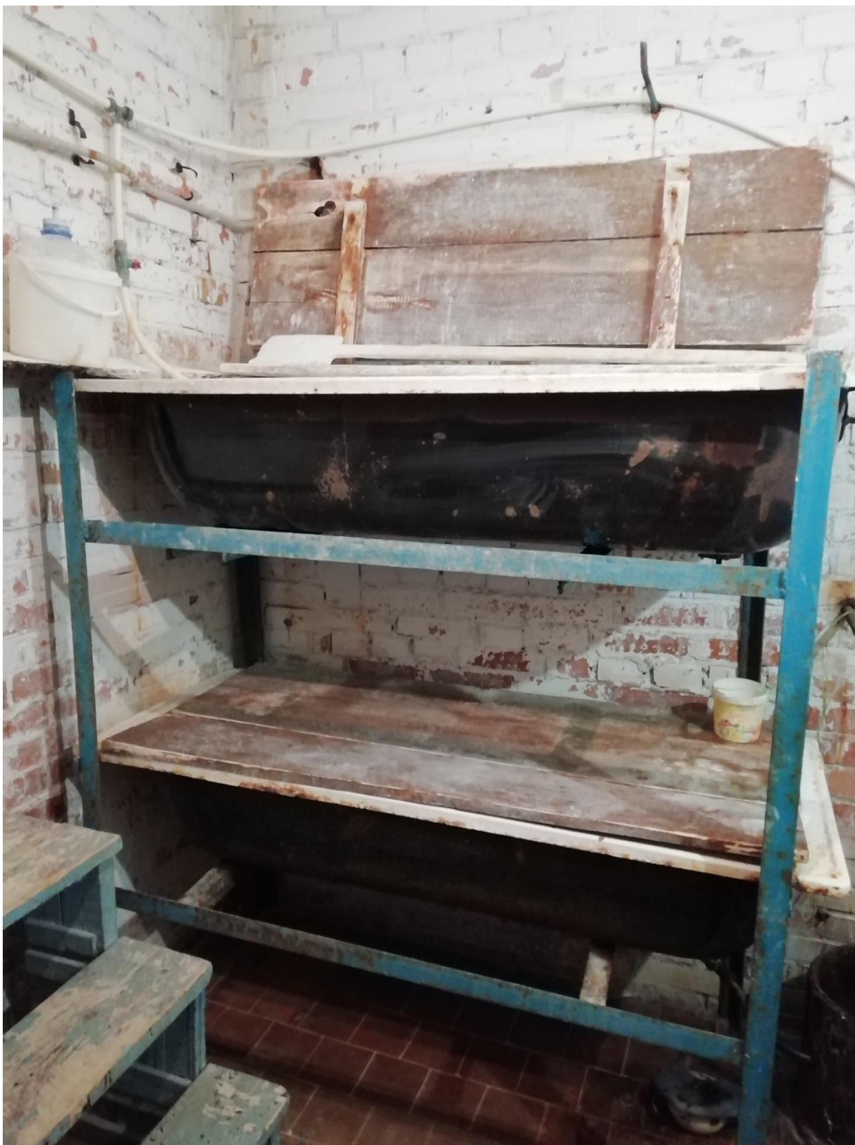
Рисунок 14. Затворная и растворная емкость в помещении хлораторной.
