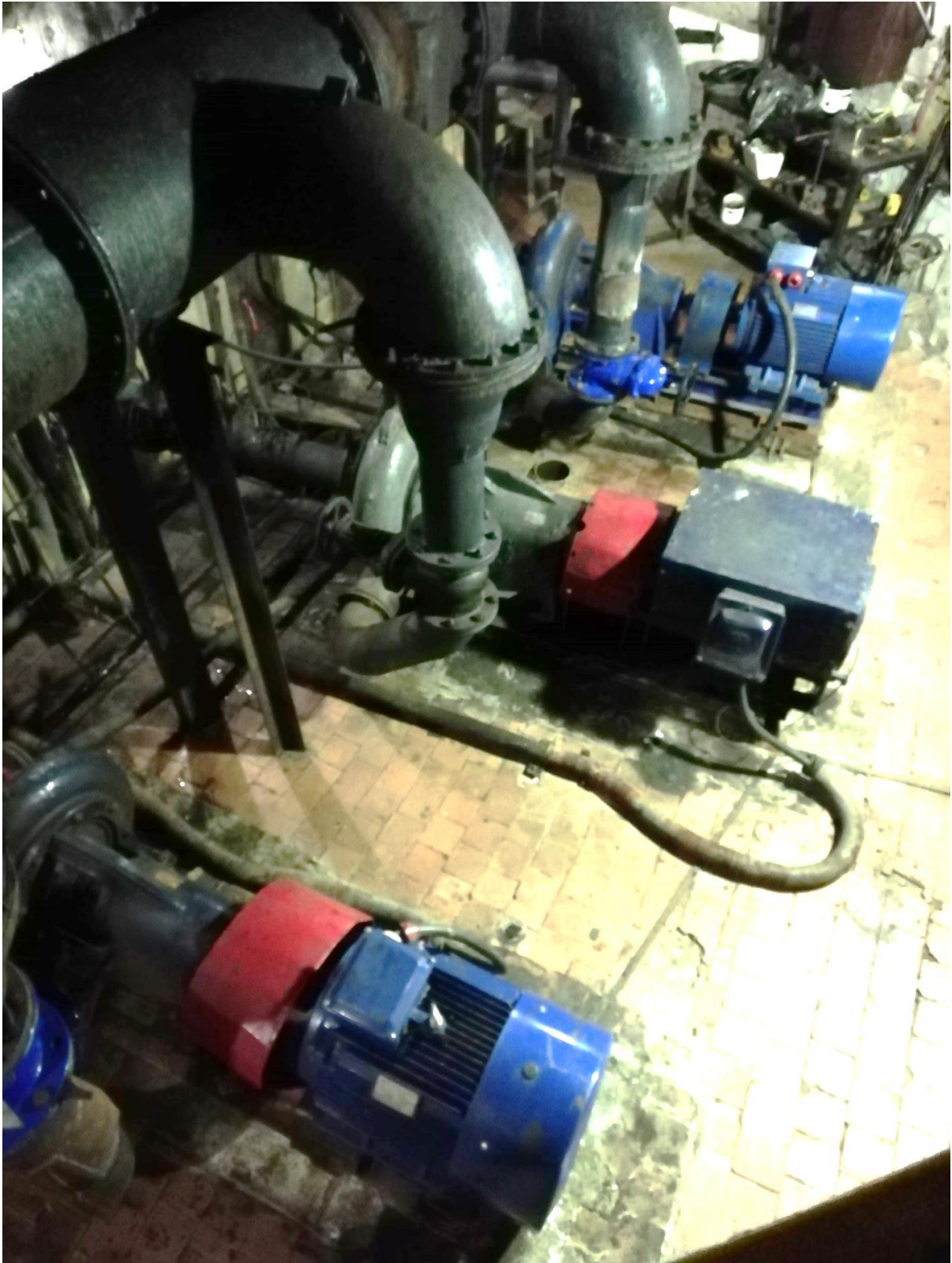
Рисунок 23. Машинный зал КНС №3.
