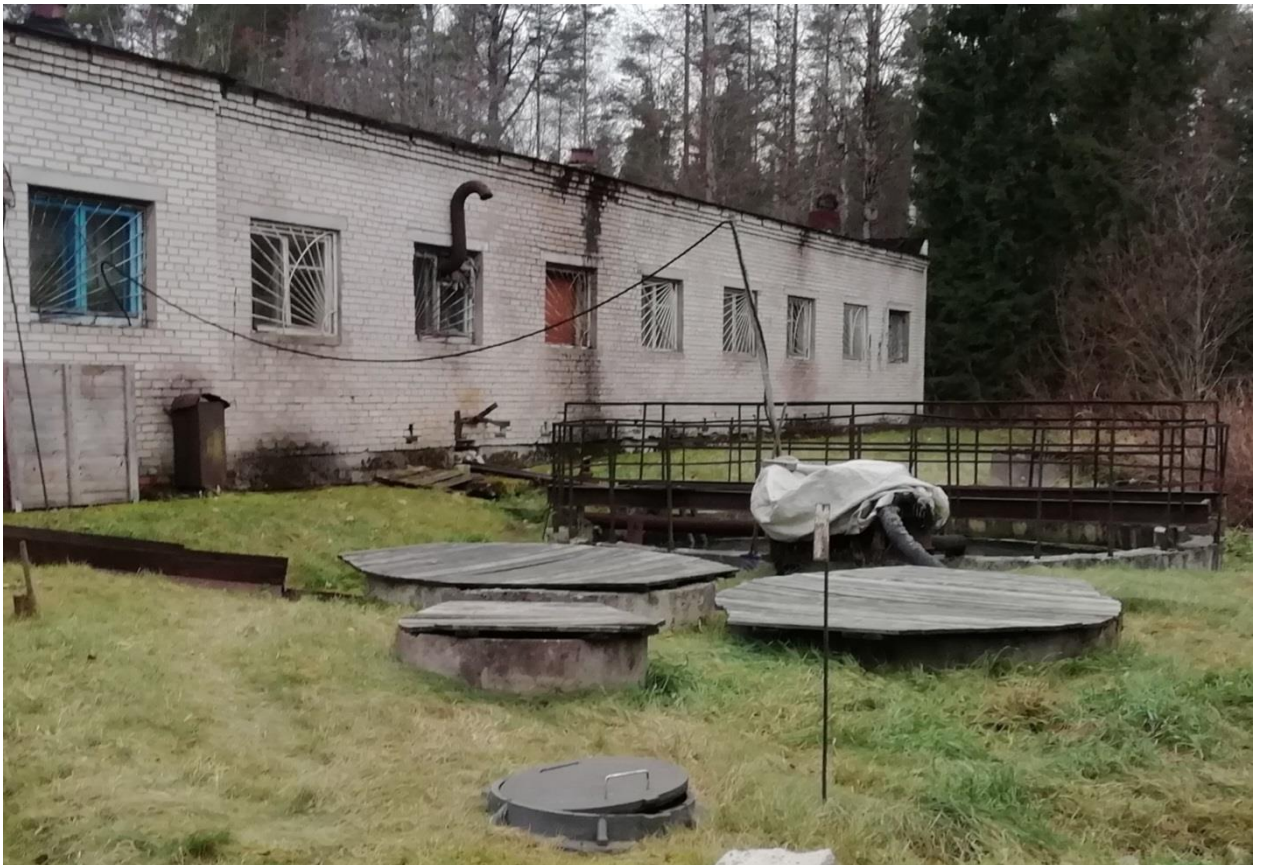
Рисунок 13. Контактные резервуары.
