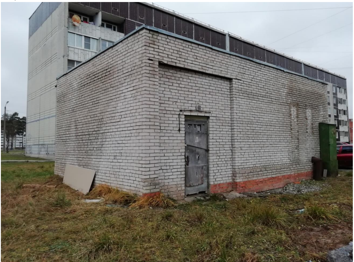
Рисунок 27. Внешний вид здания КНС №6.
