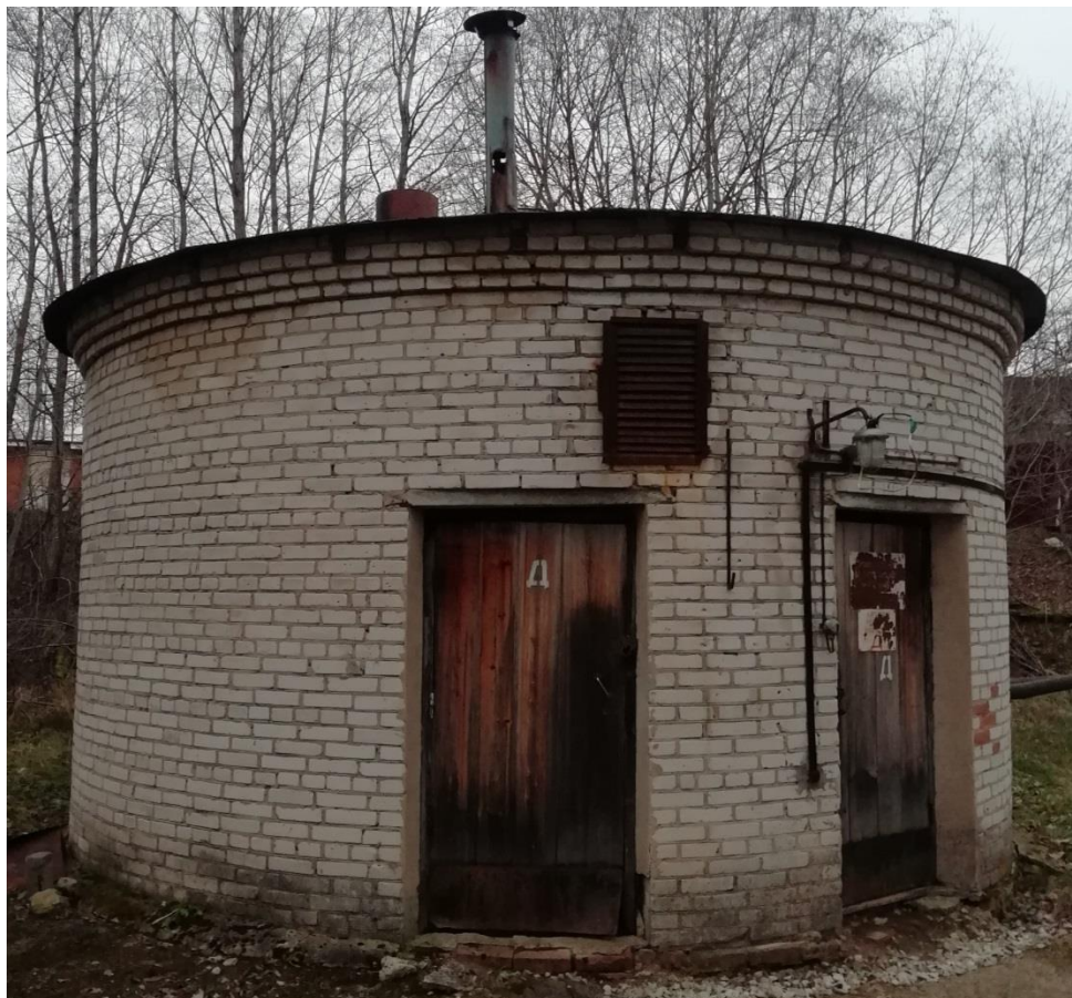
Рисунок 25. Внешний вид здания КНС №5.
