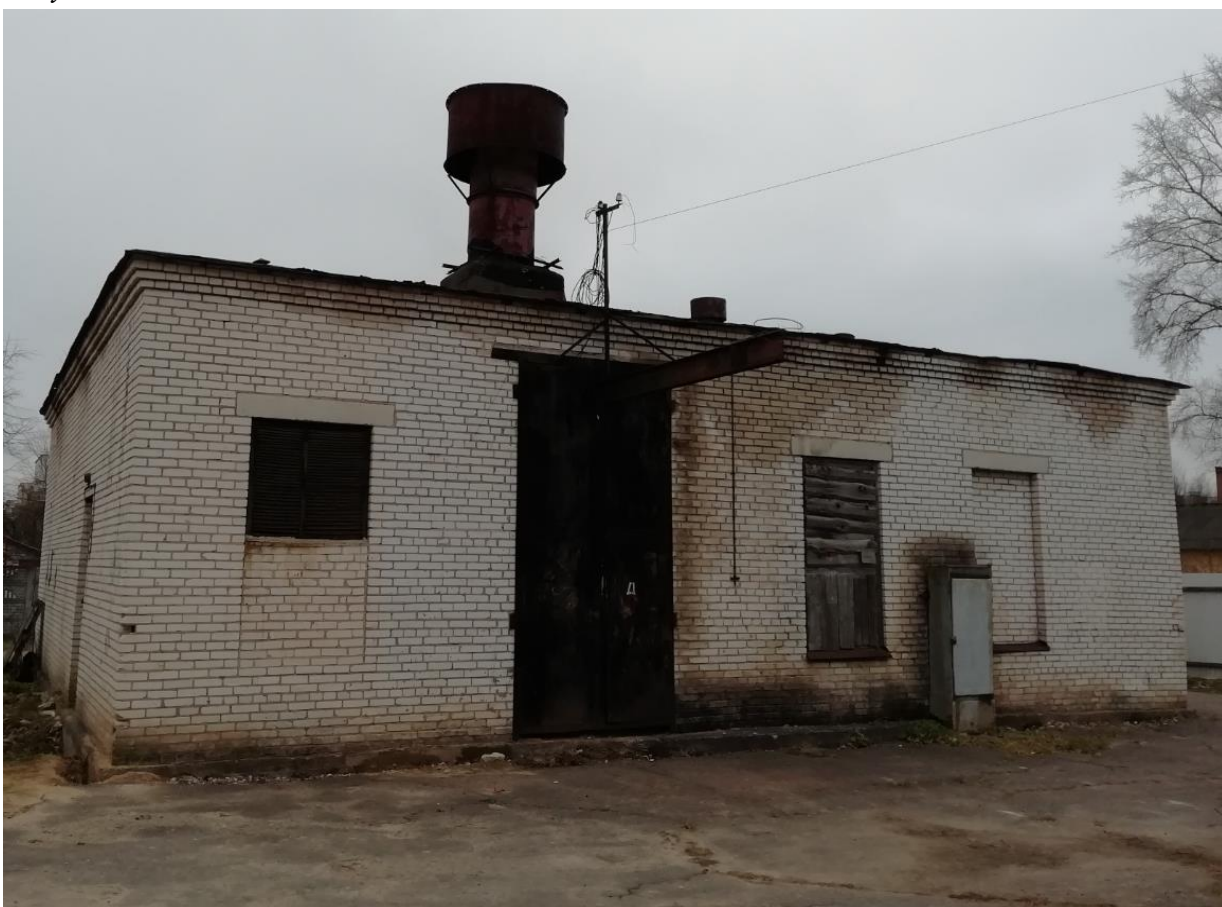
Рисунок 29. Внешний вид здания КНС №7.
