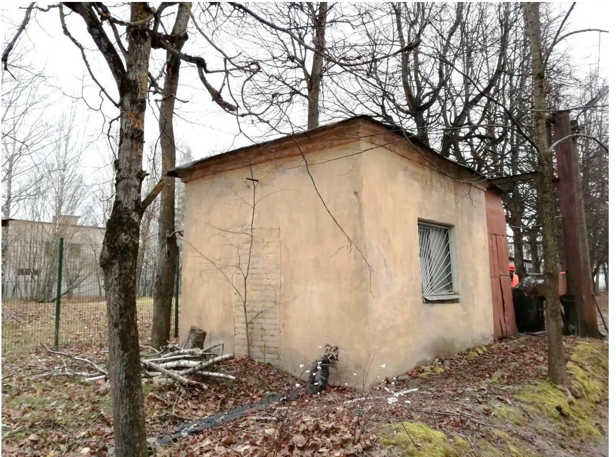
Рисунок 24. Внешний вид здания КНС №4.
