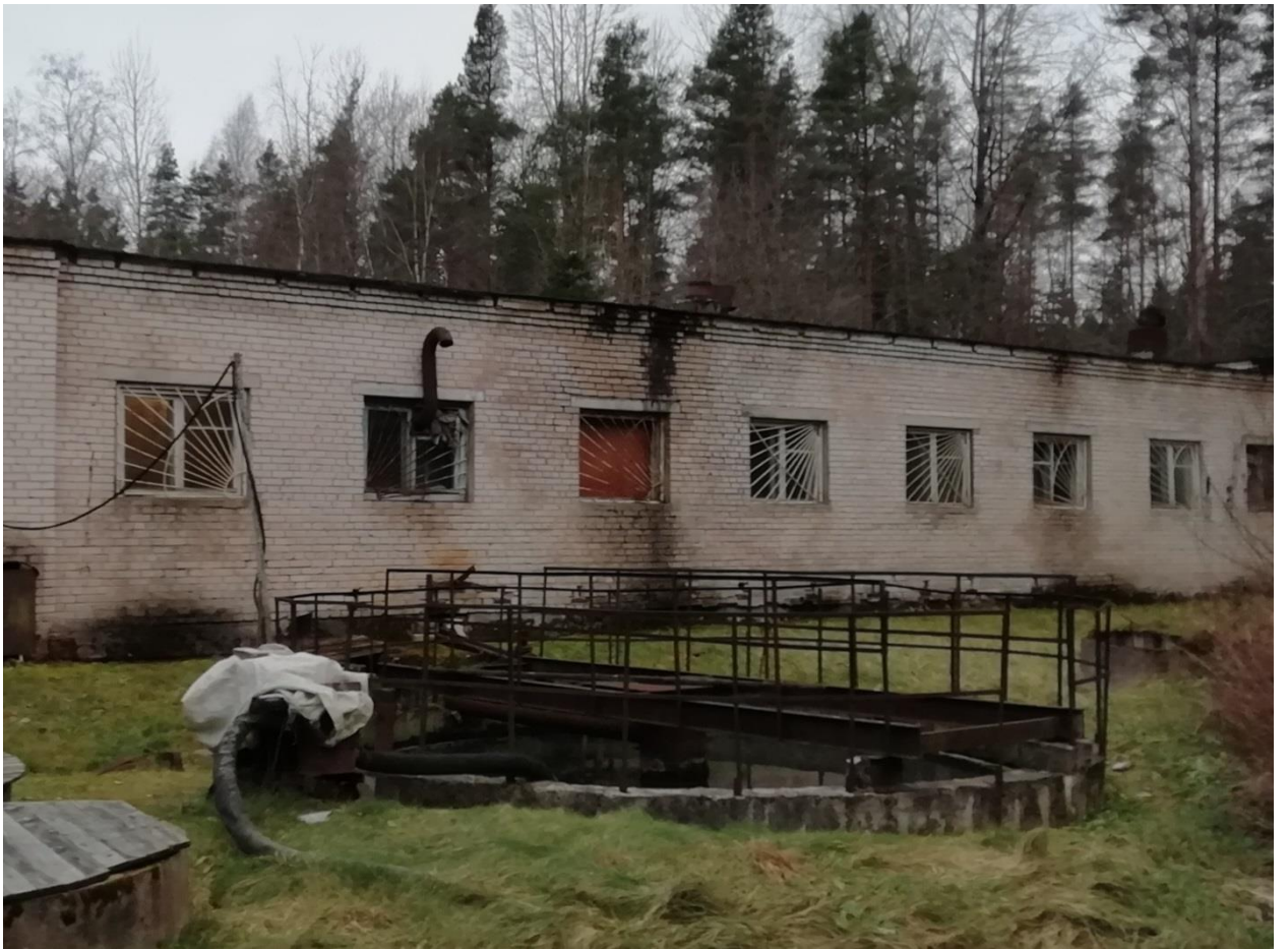
Рисунок 12. Вторичный вертикальный отстойник.
