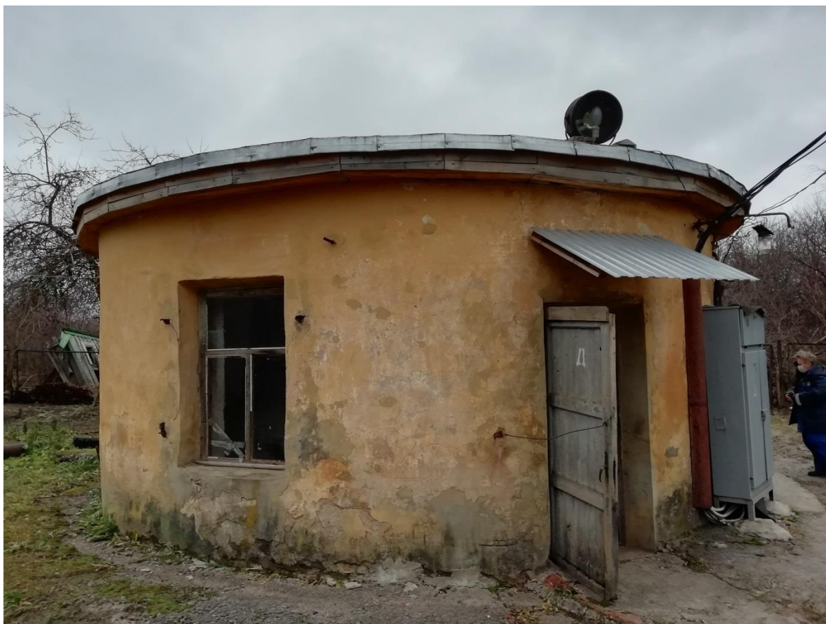
Рисунок 18. Внешний вид здания КНС №1.
