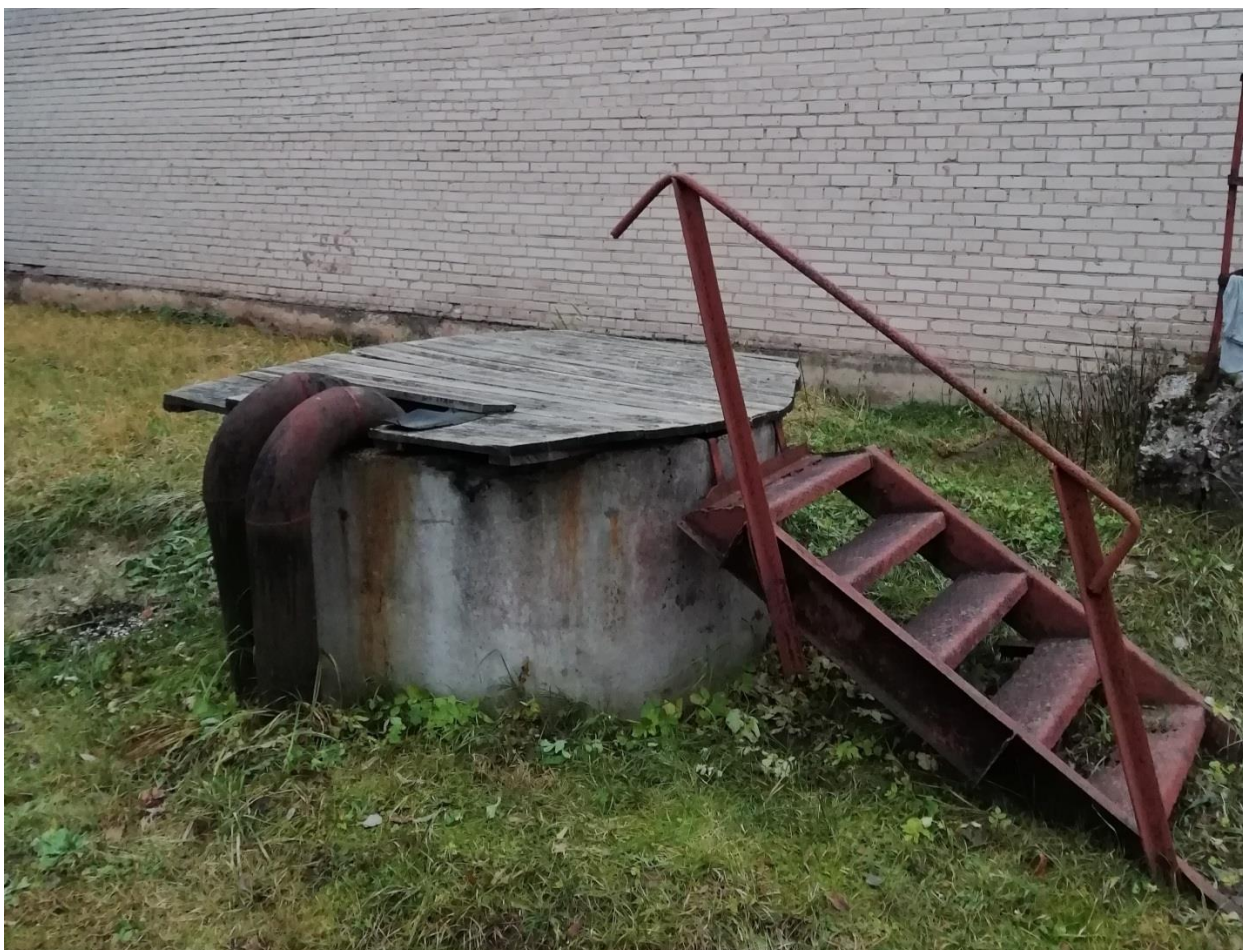
Рисунок 10. Колодец гашения напора.
