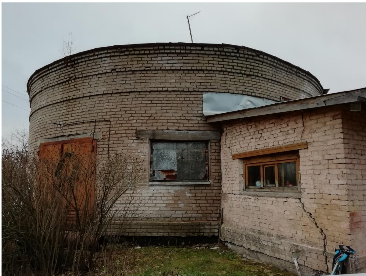
Рисунок 20. Внешний вид здания КНС №2.
